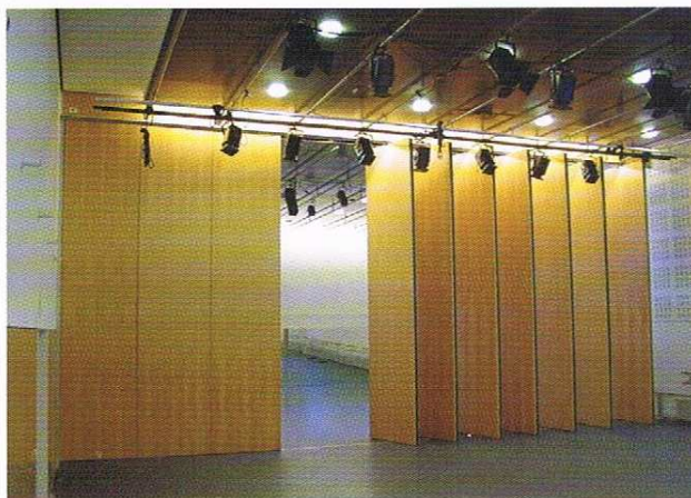
Detalle operación de cierre tabique monodireccional.
